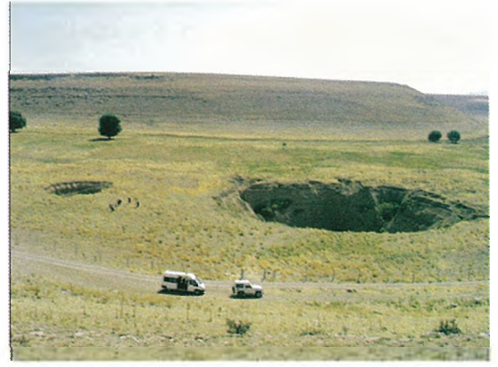
Foto-6: May Barajı Obruğları
