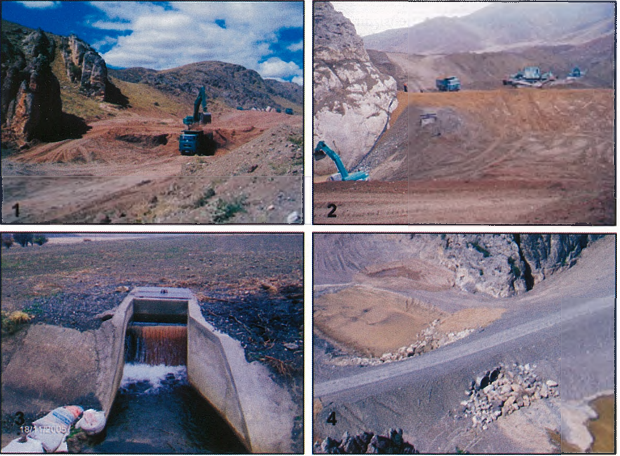
Şekil 8. Maliboğazi yeraltı barajından görüntüler (1: Kazıların başlangıcı, 2: Gövde inşaatı ve keson kuyu şeklindeki su alma yapısı, 3: Barajdan elde edilen suyun ana kanala dökülüşü, 4: İnşaatın tamamlanmasından ve yatakta düzenleme yapılmasından sonraki görünüm
