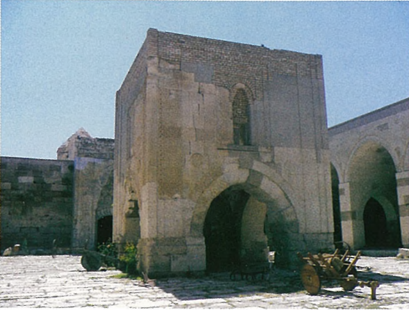
Foto-33 : Sultanhanı Kervansarayı iç mekanından bir görünüm
